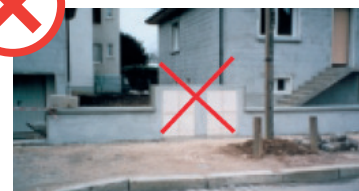
Ne pas dépasser le niveau de clôture
