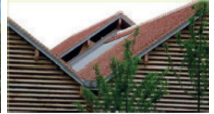
La pose de capteurs dans un espace végétalisé ou entre deux toits en limite l'impact visuel
