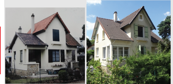
Fermeture de loggia avant et après travaux : transformation de l'équilibre de la façade
