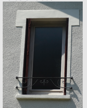
Linteau en ciment armé en surépaisseur
