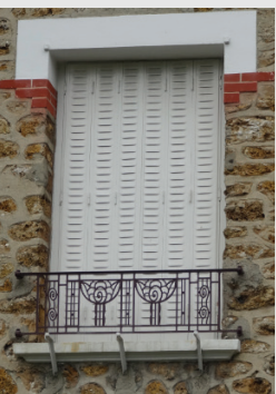
Linteau en ciment armé en surépaisseur
