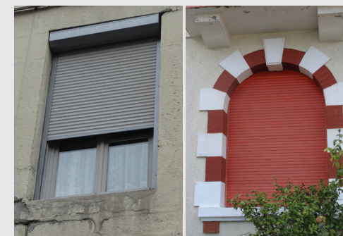
à coffrage extérieur à coffrage intérieur
