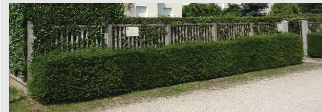
Clôtures béton de la cour d'honneur
