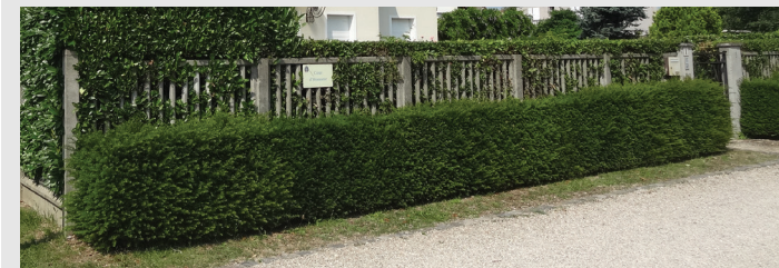
Clôtures béton de la cour d'honneur
