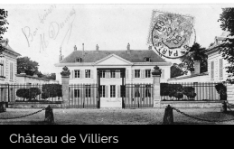
Château de Villiers
